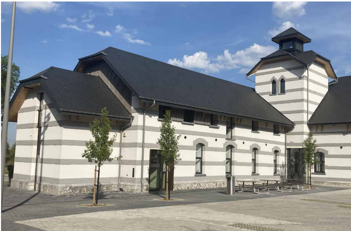
RÉNOVATION D'UNE FERME ET D'UN MOULIN, À BEAURAING.
