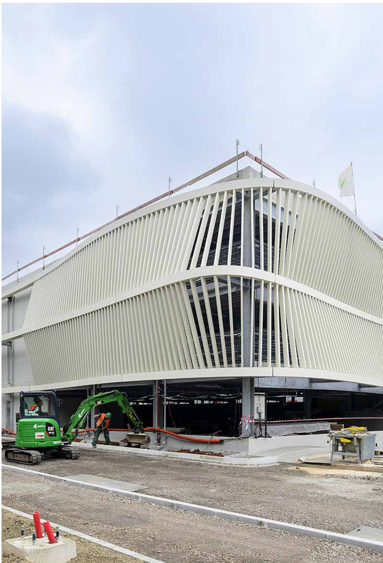
CONSTRUCTION D'UN PARKING P+R À TROISVIERGES. LES FAÇADES SONT FORMÉES DE 1.110 LAMELLES VERTICALES, BOISÉES ET EN RELIEF CÔTÉ RUE ET MÉTALLIQUES CÔTÉ VOIES FERRÉES, EN ÉCHO AUX RAILS VOISINS.
