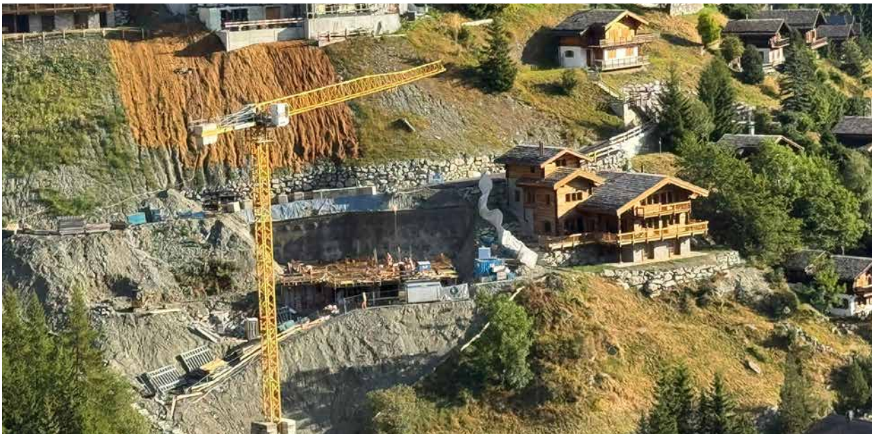
CONSTRUCTION DE DEUX CHALETS AUX DÉGÈRES.
