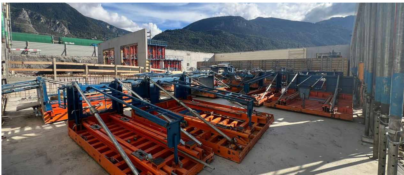
CONSTRUCTION, À SIERRE, DU CAMPUS DE L'ÉCOLE DE DESIGN ET HAUTE ÉCOLE D'ART (EDHEA).
